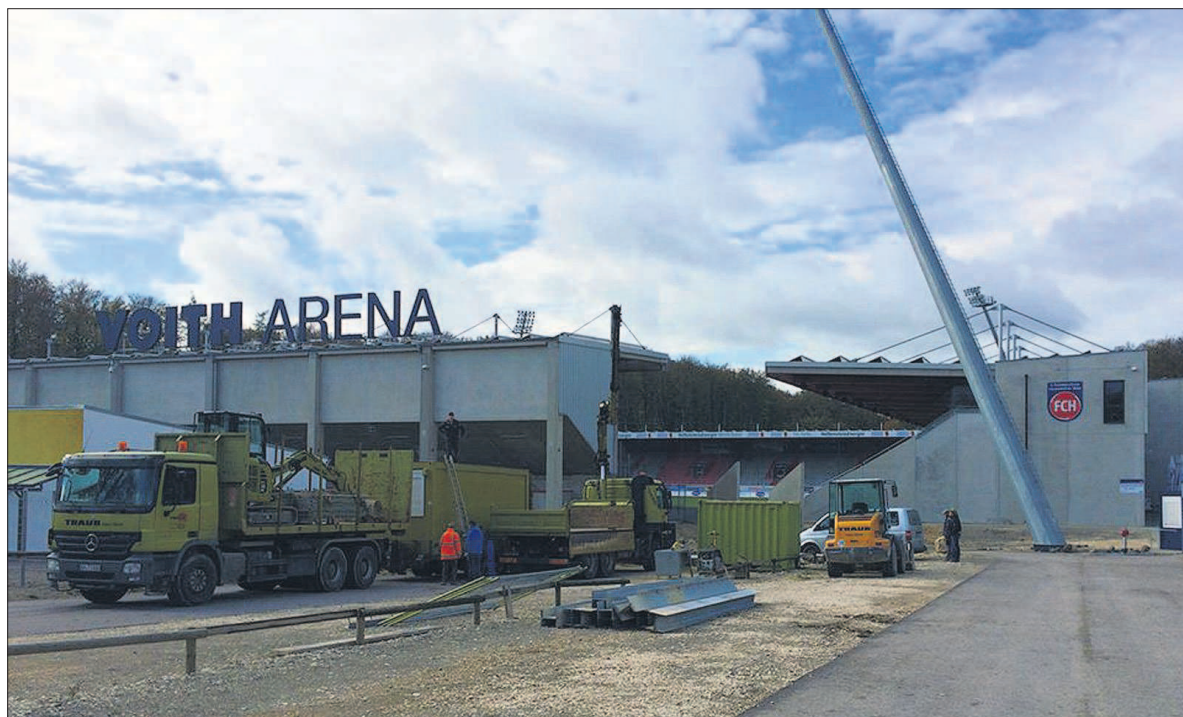
BIS ZUM FRÜHJAHR 2015 IST DIE VOITH-ARENA WIEDER EINE BAUSTELLE.
