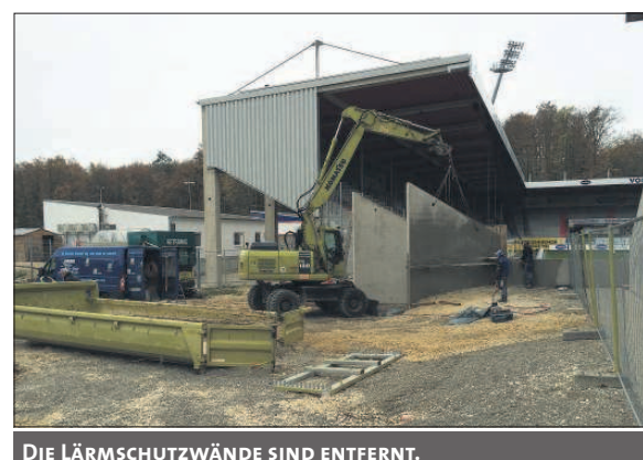
DIE LÄRMSCHUTZWÄNDE SIND ENTFERNT.
