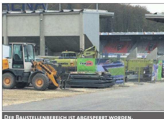
DER BAUSTELLENBEREICH IST ABGESPERRT WORDEN.
